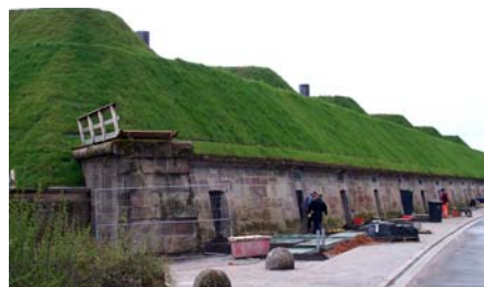
Das Bauwerk kurz nach Verlegung der vorkultivierten Gräsermatten.
