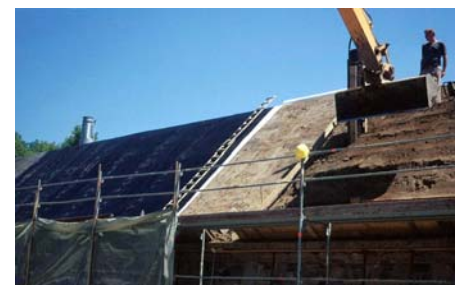
Der Bewuchs auf dem Dach wurde entfernt, die vorhandene Erde wurde modelliert (rechts) und danach mit einer wurzelfesten Abdichtungsbahn abgedeckt (links).
