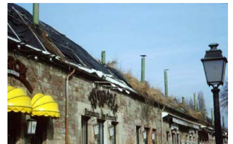
Die Kasematten vor der Renovierung im Jahr 2004.
