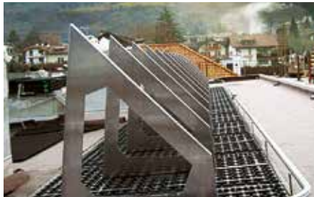
Rahmen 45° für Solar-Thermie auf 5° geneigter Dachfläche.
