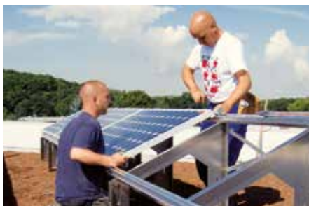
5. Die Solarmodule werden montiert.
