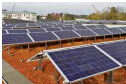
Solaraufständerung Ost-West, hier in Variante „Sattel“.
