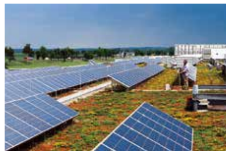
6. Das fertig begrünte Dach mit Solaranlage.
