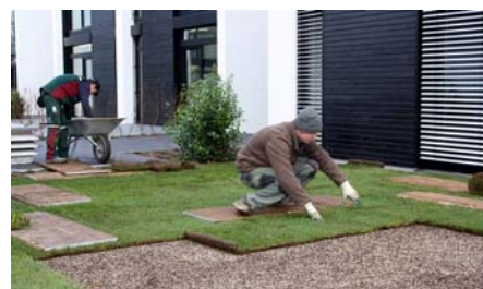
Der Rollrasen wird auf der Systemerde, dicht an dicht, verlegt.
