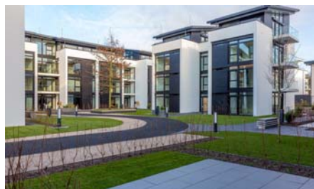
Sowohl der parkähnliche Innenhof als auch die Privatterassen liegen auf der massiven Tiefgaragendecke.
