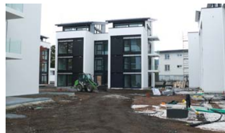
Mittels Radlader wird die Systemerde „Dachgarten“ auf der Tiefgarage aufgebracht.
