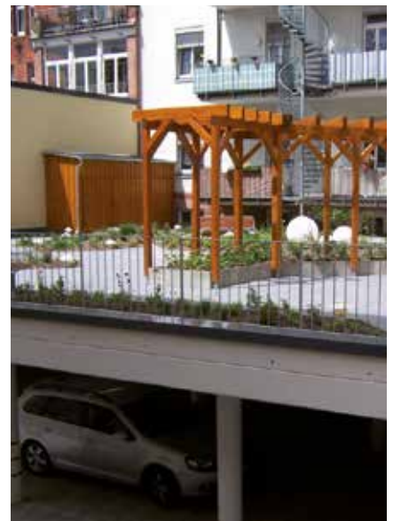
Ob als zusätzliche Rankhilfe oder einfach als Gestaltungselement verwendet, Pergolen lassen sich durchdringungsfrei integrieren. (siehe auch Abb. links unten)
