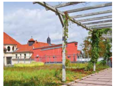
Ob als zusätzliche Rankhilfe oder einfach als Gestaltungselement verwendet, Pergolen lassen sich durchdringungsfrei integrieren. (siehe auch Abb. links unten)
