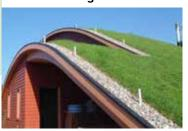
Extensive Dachbegrünungen sind auch auf geneigten Dächern einsetzbar, allerdings muss der Gründachaufbau an die veränderten Bedingungen angepasst werden. Schrägdachbegrünungen erfordern eine regelmäßige Pflege. Abhängig von Gebäude-
