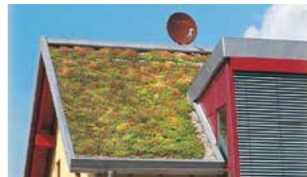
Bei diesem ca. 30° geneigten Dach wurde zusätzlich zur stabilen Traufaufkantung eine weitere Schubschwelle innerhalb der Dachfläche vorgesehen.
