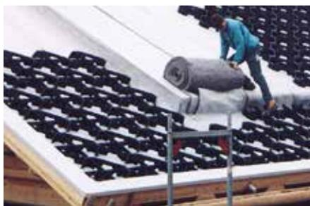
Nach Abdecken der Fläche mit der Wasserspeichermatte WSM 150 werden – beginnend von unten – die Georaster®-Elemente verlegt.
