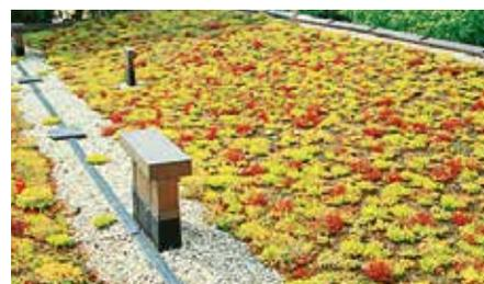
Dieses per Rinne entwässerte Dach mit einer Neigung von ca. 5° erfordert noch keine besonderen Maßnahmen.
