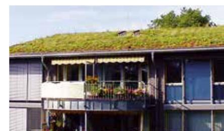
Für die Dimensionierung von Traufaufkantungen oder Schubschwellen ist nicht nur das Feuchtgewicht des Begrünungsaufbaus maßgeblich, sondern auch die örtlich anzusetzende Schneelast.
