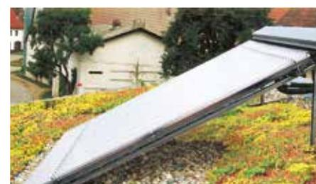
Auch auf geneigten Gründächern ist die Nutzung von Solarenergie möglich. Wie die Anlagen montiert werden können, ohne im Untergrund verschraubt zu werden, z. B. mit der ZinCo Solarbasis®, ist im Einzelfall zu klären.
