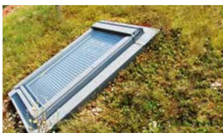
Bei Dachdurchdringungen ist darauf zu achten, dass die Abdichtung mindestens 10 cm über die Oberkante der Substratschicht herausgeführt wird. Begrünungen können zum Beispiel mittels Traufprofil TRP 140 aus Edelstahl in Kombination mit Schubhaltern (Traufschubhalter TSH oder SchubFix LF) eingefasst werden.
