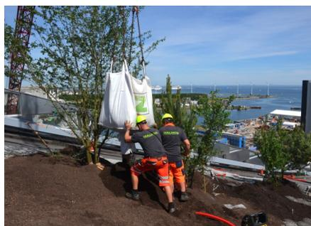
Die Wurzelballen der Gehölze werden durch speziell abgekantete Baustahlmatten abgestützt.
