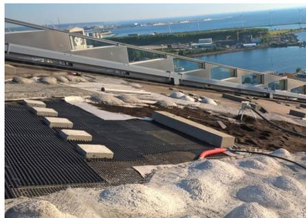
Vollflächig verlegte Protectodrain® - und Elastodrain®-Matten sorgen für die sichere Ableitung von Überschusswasser.
