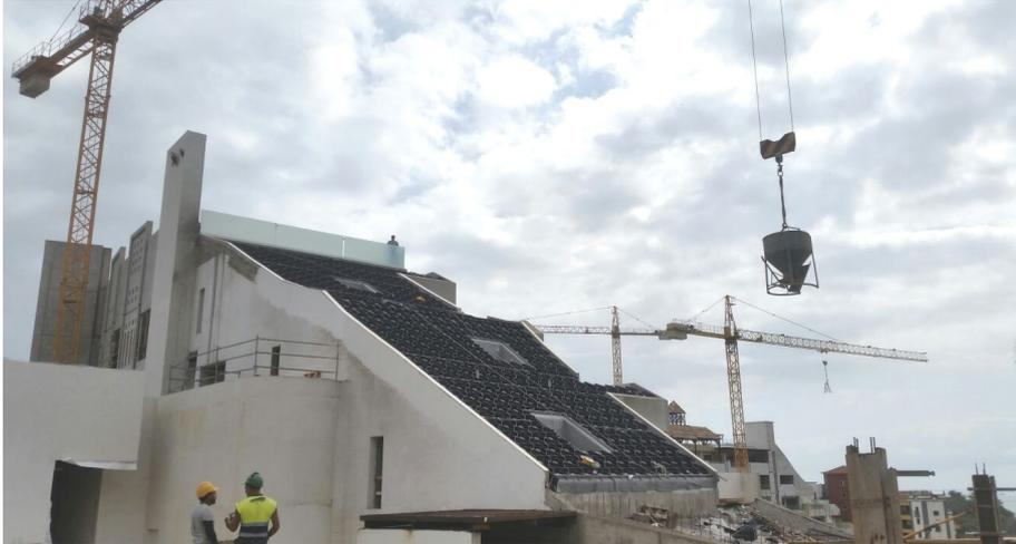
Blick auf eines der drei Schrägdächer nach Einbau von Schubsicherung und Georaster.
