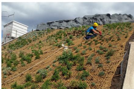
Vor Einbringen der Pflanzen wurde das Substrat mit Netzen aus Kokosfasern gegen Erosion gesichert. Statt der für Steildächer üblichen Sedummattenbepflanzung wurden heimische und auf das Klima abgepasste Stauden und Sträucher ausgewählt, die sich dank der Bewässerung gut und schnell entwickelten.
