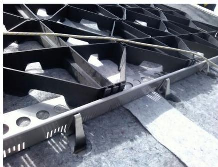
Detailblick auf die eingebauten Schubsicherungen mit Traufprofil TRP 80, Georaster und WSM 150.
