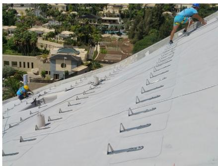
Zur Schubsicherung waren mehr als 700 Schubfixe des Typs LF 300 auf den Steildächern einzubauen.
