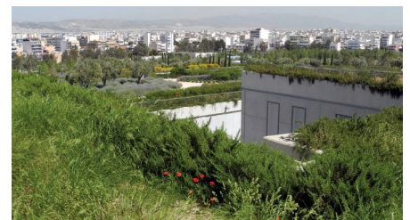
Ein Blick zwischen Oper und Bibliothek hindurch auf das tiefer liegende Parkhausdach.
