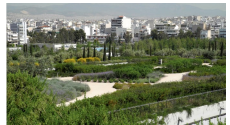
Unter den Wegen des Parkhauses kam Protectodrain® PD 250 zum Einsatz.
