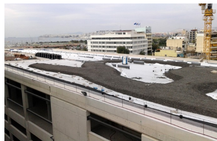
Um teilweise höhere Aufbauten zu erreichen kam Schaumglasschotter zum Einsatz.
