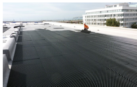
Unter den Vegetationsflächen sorgen Floradrain® FD 40-Elemente für die Ableitung von Überschusswasser.
