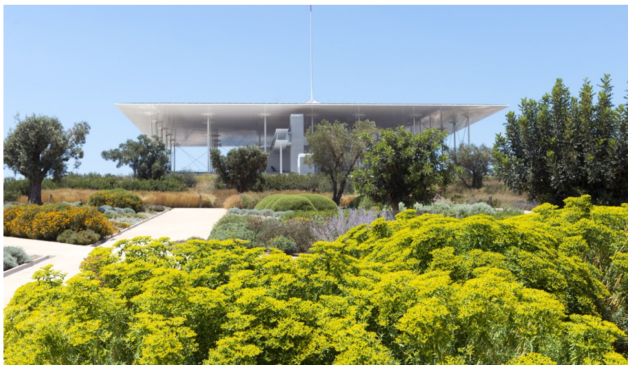
Über der Dachterrasse der Oper befindet sich ein etwa 10.000 m 2 großes Solardach.
