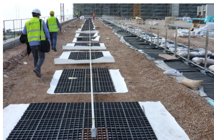
Die Absturzsicherung bilden sowohl Geländer, als auch Schienen mit beweglichen Anschlagspunkten.
