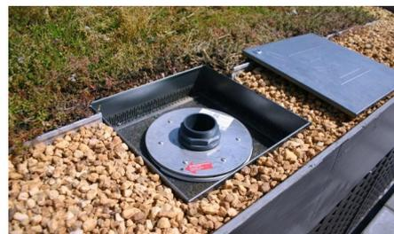
Das Retentions-Drossel-Set befindet sich über dem Dachablauf.
