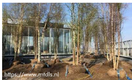
Die Wurzelballen werden im Boden verankert, um den hohen Windlasten auf dem Dach standzuhalten.
