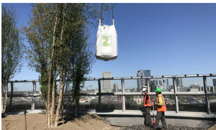
Das Substrat und die Bäume werden mit einem Teleskopkran aufs Dach gebracht.
