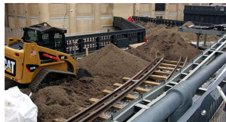
Das Substrat wurde in einer mittleren Dicke von 45 cm eingebaut.
