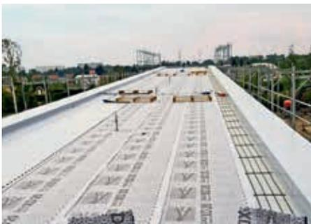
Grundlage ist der Systemaufbau „Steinrosenflur“, hier das Drainage-Element Fixodrain® XD 20.
