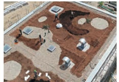
Sand-, Lehm- und Kiesbereiche sowie Substratanhügelungen strukturieren die Fläche.
