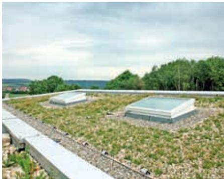
Das verwendete Substrat ist eine spezielle Mischung aus Kalksplitt, Lava und humosem Anteil.
