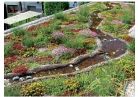
*Insekten und Vögel benötigen Wasserflächen: diese lassen sich mittels Folien auf dem Dach installieren.*
