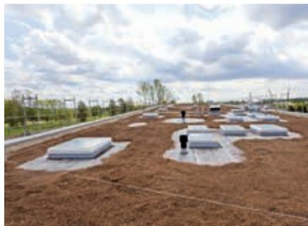
Die fertig eingebaute Systemerde „Steinrosenflur“.
