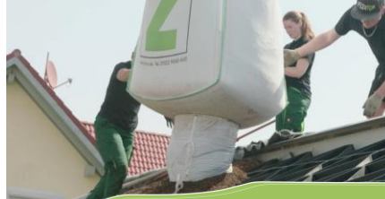
Verlegeschritte: Substrat-Aufbringung
