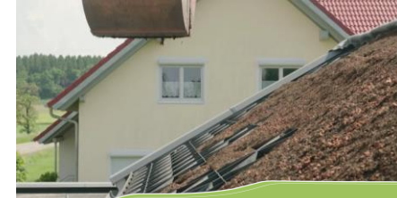
Verlegeschritte: Substrat-Aufbringung
