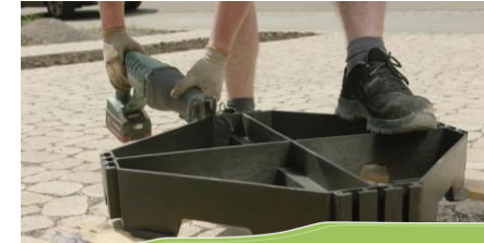
Verlegeschritte: Zuschneiden Georaster
