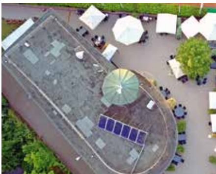
Das Dach des KETV als „nacktes“ Bitumdach vor der Neugestaltung zu einem Gründach.
