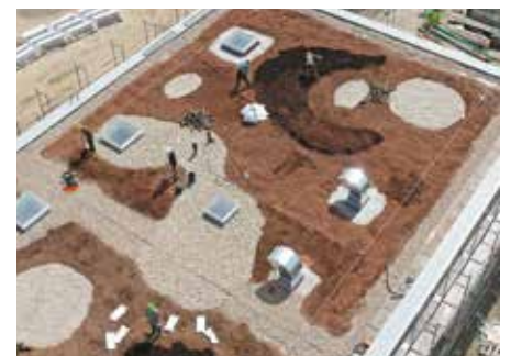
Sand-, Lehm- und Kiesbereiche sowie Substratanhügelungen strukturieren die Fläche.
