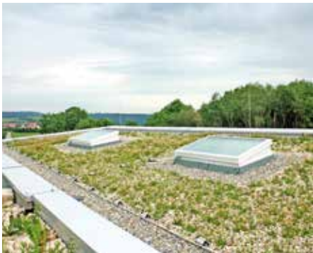
Das verwendete Substrat ist eine spezielle Mischung aus Kalksplitt, Lava und humosem Anteil.
