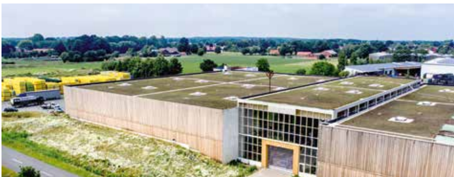
In Kooperation mit der Hochschule Osnabrück entstand die ca. 10.000 m 2 große Dachbegrünung mit regionaltypischer Biodiversität auf dem Hallendach der Firma Lütvogt.
