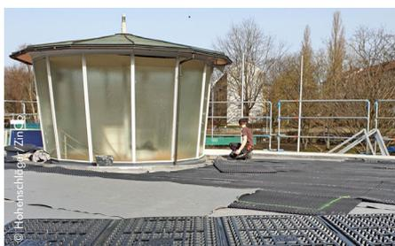
Die Drän- und Wasserspeicherelemente Floradrain® FD 25 wurden vollflächig verlegt und im Bereich der Solaranlage von den Solarbasis-Platten SB 200 ergänzt.
