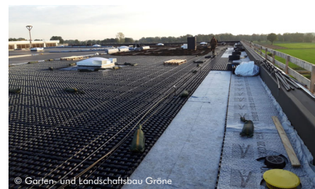
Eine Teilfläche des Daches wurde mit dem Wasserverteil-, Speicher- und Dränelement Aquatec® AT 45 samt Tropfschläuchen belegt.
