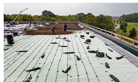
Eine andere Teilfläche erhielt die Drainage-Rollenware Fixodrain® XD 20 mit Aquafleece – hier zu sehen: die Unterflur-Bewässerung mit Tropfschläuchen.
