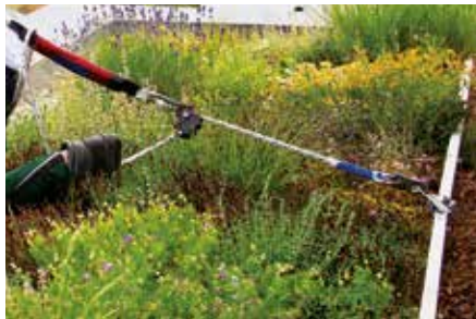
Die Anschlagvorrichtung im Einsatz. Der horizontal bewegliche Läufer für die persönliche Schutzausrüstung sorgt für maximale Benutzerfreundlichkeit.
