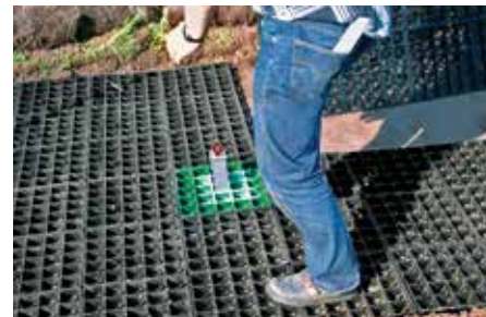
In Summe sind es vier vorgesteckte Elemente, die eine kraftverteilende Scheibe von ca. 5,3 m² ergeben.
