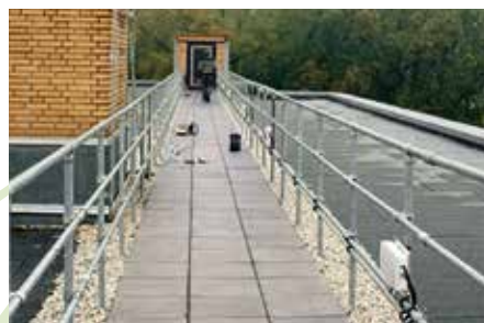
Für die beidseitige Geländereinfassung eines Fluchtweges wird die Pfostenaufnahme der Geländerbasis GB objektspezifisch mit einem zusätzlichen, zweiten Schraubflansch gefertigt.
