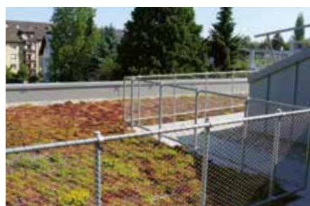
Auf der Geländerbasis lassen sich auch individuelle Geländerlösungen montieren. Das Bindeglied ist dabei der Gegenflansch. Ansonsten sind Ihrer Kreativität keine Grenzen gesetzt.
