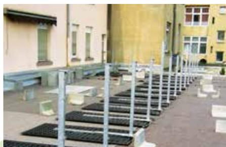
Nach Aufbringen einer Schutzlage über der Dachabdichtung werden die Geländerbasen GB/GB-Eck ausgerichtet und die Pfosten sowie ggf. die Halter für die Anschlagsschiene montiert.
