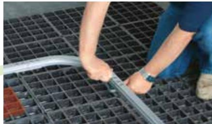
Das Fallnet® SR Rail wird mit einfachen Handgriffen ohne Spezialwerkzeug zusammengesetzt. Schnell sind große Abschnitte durch Rasterelemente, Schienenhalter und die Schienen miteinander verbunden.
