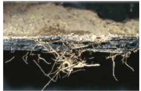
Eine von Wurzeln durchdrungene Bitumenabdichtung ohne Wurzelschutzausrüstung.
