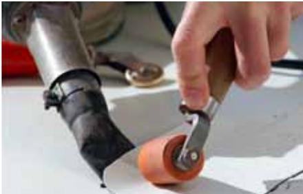
Nach einer gründlichen Reinigung der Dachfläche werden die in 2,44 m breiten Rollen gelieferten Wurzelschutzbahnen des Typs WSB 100-PO ausgerollt. Die Bahnenstöße sind sowohl längs als auch quer mit mind. 5 cm zu überlappen. Das Verschließen der Nähte erfolgt ausschließlich durch Heißluftverschweißen. Beim Heißluftschweißen können sowohl Handschweißgeräte verwendet werden, gegebenenfalls auch Schweißautomaten zum „Bahenschweißen“. Detaillierte Hinweise zum Schweißen der Wurzel-
