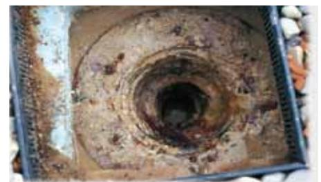
Schutzschichten aus Beton bergen das Risiko der Versinterung der Dachabläufe. Mit Schutzlagen aus Synthesefasern oder Kautschuk kann dies verhindert werden.
