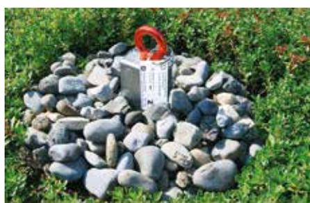
Jedes Fallnet® SR wird mit einer Kennzeichnungsplakette am Anschlagpunkt ausgeliefert. Auf dieser finden Sie neben der Produktbezeichnung, der Prüfnorm, dem Herstellungsdatum auch die Seriennummer. Somit lässt sich im Bedarfsfall auch noch nach Jahrzehnten dokumentieren, wie, für welches Objekt und durch wen das Fallnet® SR eingebaut wurde.
