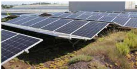
Bei der Variante „Schmetterling“ stoßen die beiden Grundrahmen mit der niedrigen Seite aneinander, so dass Niederschlagswasser mittig auf die SB 200-Platte geleitet und dort in beide
