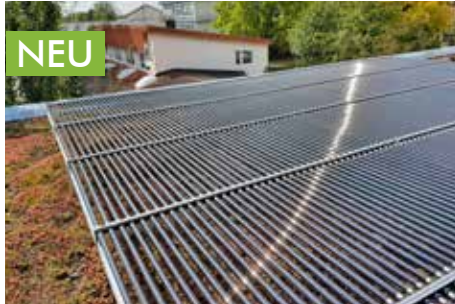
Dachbegrünung und Solar
