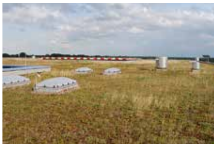
Ein klassischer Extensiv-Dachbegrünungsaufbau (Typ „Sedumteppich“) verdunstet in sommerlicher Trockenheit 20–50 l/d .
