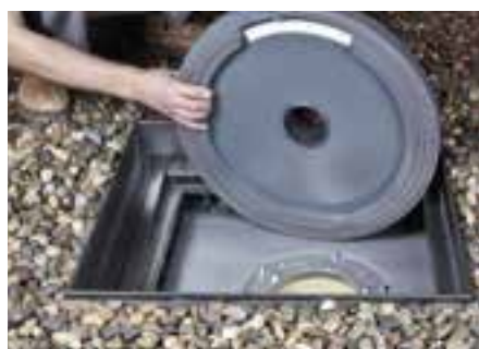
Das Retentionsdrossel-Set RDS 48 wird eingesetzt beim Einbau über Flachdachabläufen mit Schraubflansch.
