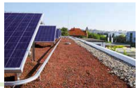
Dachdurchdringungsfreier Einbau, da die nötige Auflast lediglich mit Zincolit® bzw. Systemerde oder alternativem Schüttgut erbracht wird.
