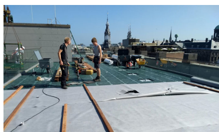
Der Systemfilter PV verhindert das Auswaschen von Feinteilen in die Spacer-Elemente.
