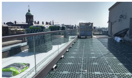
Die RSX 65 Spacer-Elemente werden auf der Speicherschutzmatte SSM 45 verlegt.
