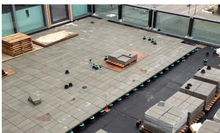
Die Terrassenplatten auf den Dachflächen liegen auf höhenverstellbaren Elefeet® Stelzlager.
