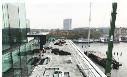
Die Pflanzbeete wurden mit dem Systemaufbau „Dachgarten“ mit Floradrain® FD 40-E ausgeführt.
