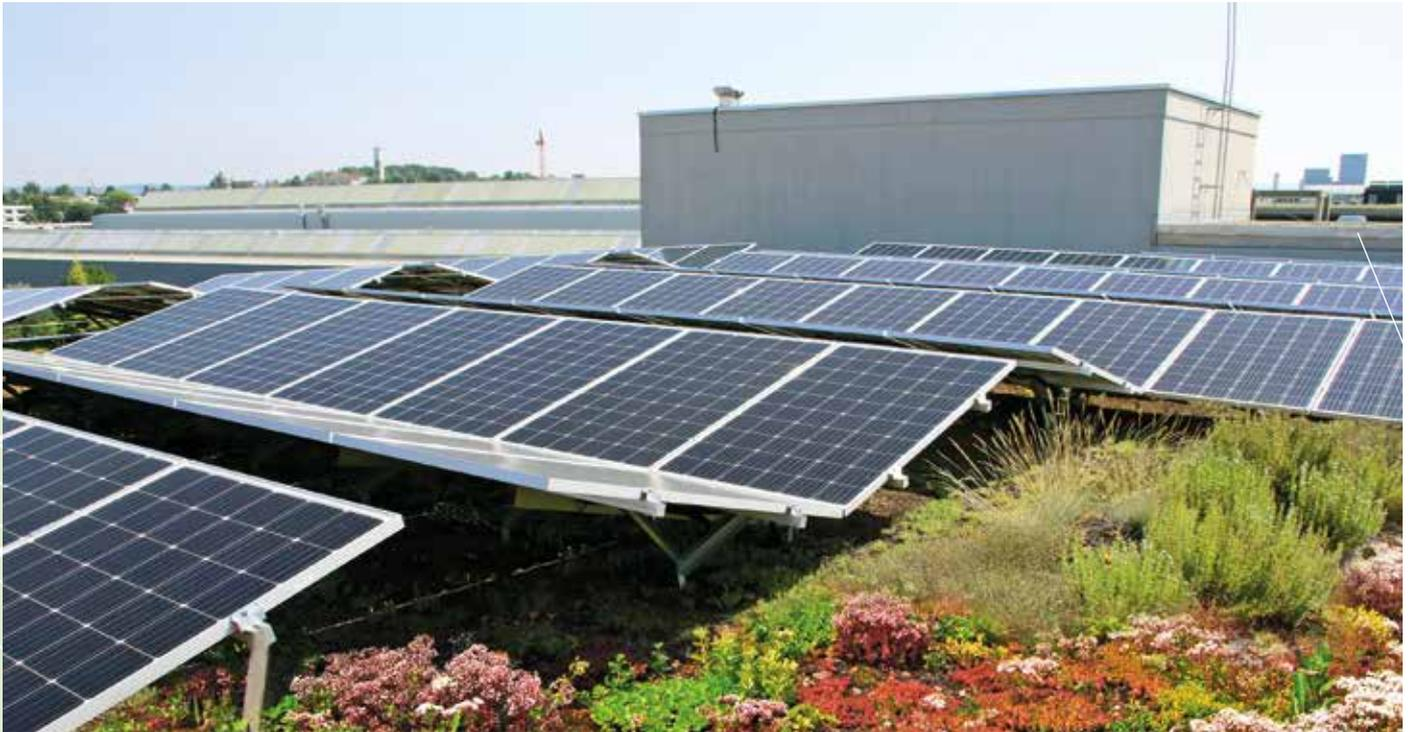
Module in Ost-West-Ausrichtung können in Form eines „Satteldachs“ oder eines „Schmetterlings“ ausgeführt werden. Bei der Variante „Schmetterling“ stoßen die beiden Grundrahmen mit der niedrigen Seite aneinander, so dass Niederschlagswasser mittig auf die ZinCo Solarbasis®
