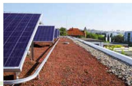
*Dachdurchdringungsfreier Einbau, da die nötige Auflast lediglich mit ZinCo Systemerde oder alternativem Schüttgut erbracht wird.*
