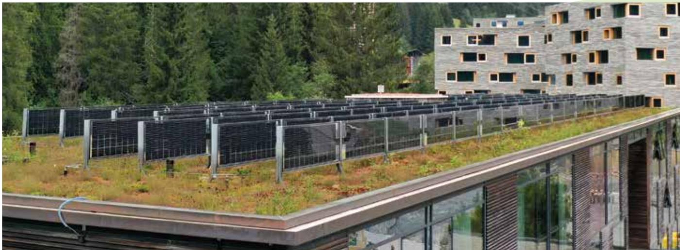
„SolarVert®“ mit senkrechter Modul-Anordnung vereint die Vorteile der Ost-West und der Südausrichtung. Durch geeignete Pflanzenauswahl oder helle Untergründe kann die Leistung sogar noch weiter optimiert werden.
