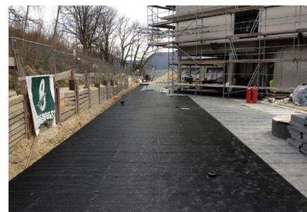
Im Zufahrtsbereich wurde Elastodrain® EL 202 vollflächig verlegt und mit passenden Verbindern fixiert.
