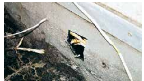
Bereits durch die Abdichtung gewachsene Bambusrhizome
