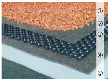
Systemaufbau „Steinrosenflur“
