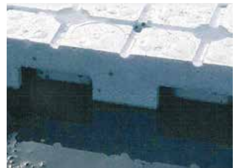
Die Lösung: ausreichend hohe Drainage mit Kapillarbruch.
