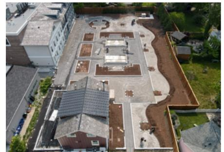
Die im Bau befindliche Dachfläche kurz vor dem verlegen der Terrassenplatten und der Bepflanzung.
