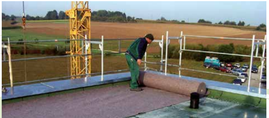
ZinCo-Schutzmatten bieten mechanischen Schutz und speichern zudem Feuchtigkeit.
