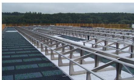
Zwischen den Solarbasisplatten kam Floradrain<sup>®</sup> FD 40 als Drainageelement zum Einsatz.
