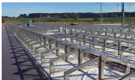
Die Solar-Grundrahmen wurden auf der Solarbasis SB 200 befestigt, auf die zuvor ein Filtervlies verlegt wurde.
