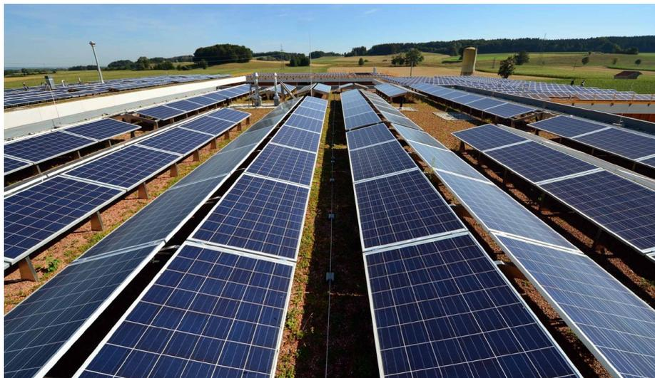
Um über den Tag verteilt eine möglichst gleichmäßige Energieausbeute zu haben, wurde eine Hälfte der Panels nach Süden ausgerichtet, die im Bild zu sehende andere Hälfte erhielt eine Ost-West-Ausrichtung.
