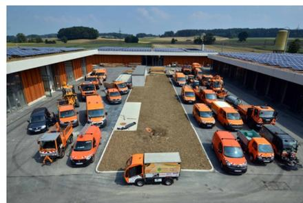
Auf dem Dach des linken Gebäudes wurde die Ost-West Variante verbaut, auf den anderen zwei Gebäuden die „klassische“ Südausrichtung.
