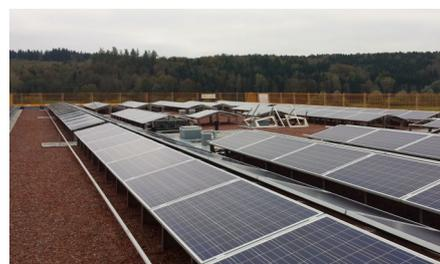
An der Solarbasis SB 200 wurde zusätzlich ein Schienensystem zur Absturz-sicherung befestigt.
