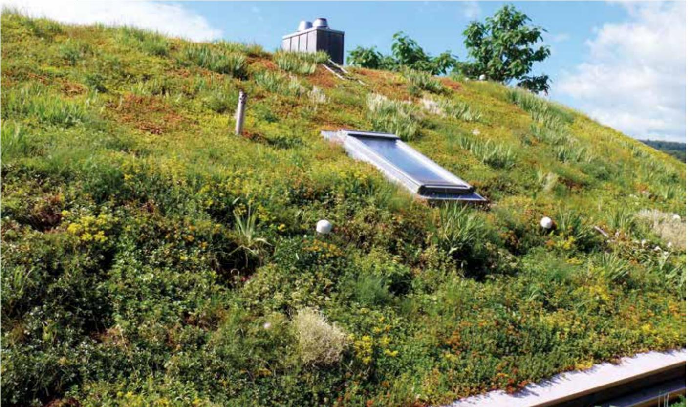
Mit dem hier vorgestellten Systemaufbau „Begrüntes Steildach“ auf Grundlage der ZinCo Georaster®-Elemente wird auch die Begrünung von Dachflächen mit über 25° Neigung möglich. Die ca. 54 × 54 cm großen und 10 cm hohen Georaster®-Elemente aus Recycling-Polyethylen (HD-PE) werden ohne Werkzeuge einfach ineinandergesteckt. Dies bewirkt sofort einen stabilen, flächigen Verbund. Eine mit den Raster-Elementen belegte Fläche ist sicher begehbar und mit Systemerde befüllbar.
