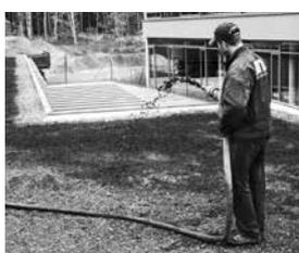
Die ZinCo Anspritzbegrünung ist rationell für große Flächen – sie bringt in einem Arbeitsgang Mulch- und Trägermaterial, Kleber, Nährstoffkomponenten sowie Saatgut auf. Die Vegetationstragschicht wird oberseits erosionssicher fixiert. Ebenso das Saatgut oder/und Sedum-Sprossen.
