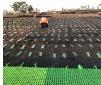
Das Substrat unterhalb der Kunststoffmatten liegt eingepackt zwischen zwei Lagen Geogitter.
