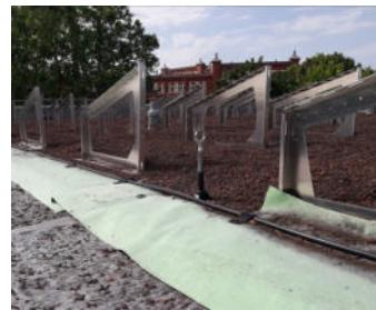
Auf Fixodrain® XD 20 sind die Solarbasisplatten SB 200 mit den Solargrundrahmen platziert. Darüber liegt das Aquafleece® AF 300 (grün) mit seinen Tropfschläuchen.
