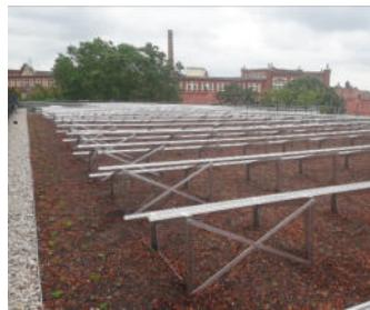
Die Windverbände im Randbereich stabilisieren die Solargrundrahmen. Jetzt ist alles für die Montage der Module bereit.
