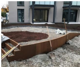
Die Ausstattungselemente aus Cortenstahl werden punktuell einbetoniert, darunter sichert Floradrain® FD 60 neo die durchgängige Dränage.
