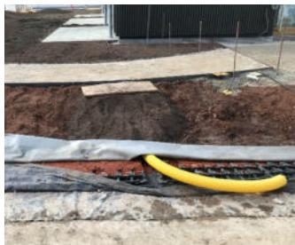
Oberhalb der mit dem Systemfilter abgedeckten Dränageschicht Floradrain® FD 60 neo variiert der weitere Aufbau für die begrünten bzw. die befestigten Flächen.
