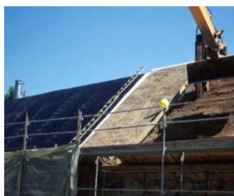
Der Bewuchs auf dem Dach wurde entfernt, die vorhandene Erde wurde modelliert (rechts) und danach mit einer wurzelfesten Abdichtungsbahn abgedeckt (links).
