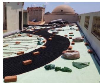
Die Drän- und Wasserspeicherelemente Floradrain® FD 40 liegen vollflächig auf dem Dach und in den Pflanzbereichen ist zur Unterflurbewässerung das Aquafleece® AF 300 mit seinen Tropfschlüchtern verlegt.
