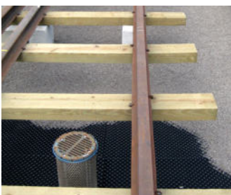
Unter den Schienen befindet sich ein Gründachaufbau mit verfüllten Floradrain®-Elementen als Dränschicht.
