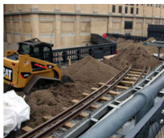
Das Substrat wurde in einer mittleren Dicke von 45 cm eingebaut.
