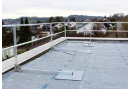
Hier sieht man die Pfostenmodule vor dem Aufbringen des Begrünungs-Systemaufbaus.
