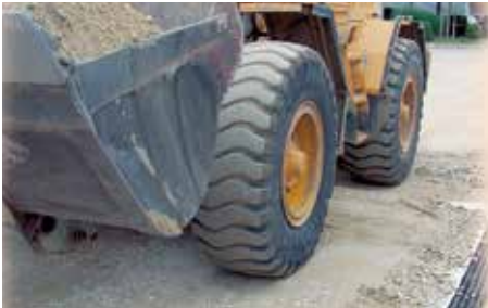
Der „Vor-Kopf-Einbau“ der Tragschicht und von den darüber liegenden Schichten ist auf Elastodrain® EL 202 selbst mit schwerstem Gerät möglich.
