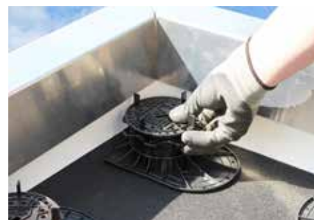
Aufstockelemente Elefeet® A 12, A 22 und A 67, stufenlos mehrfach kombinierbar bis zu einer Aufbauhöhe von ca. 500 mm
