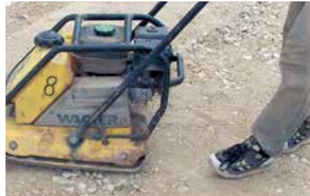
Die Schottertragschicht muss vor Aufbringen des Pflasterbelages oder einer Asphaltdecke verdichtet werden. Mit welcher Rüttelplatte dies am besten erfolgt, hängt unter anderem von der Dicke der Tragschicht und der Schwingungsanfälligkeit des Bauwerks an sich ab und muss vor Ort überprüft werden.
