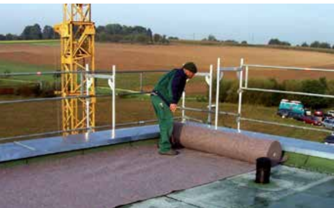
Zinco-Schutzmatzen bieten mechanischen Schutz und speichern zudem Feuchtigkeit.
