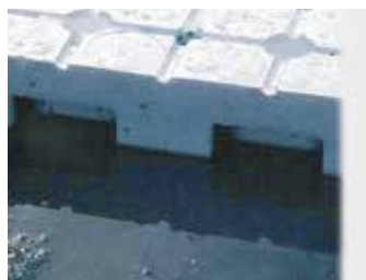
Die Lösung: ausreichend hohe Dränage mit Kapillarbruch.
