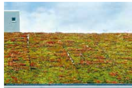
Fugen bei Vegetationsmatten
