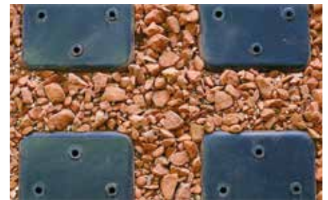
Verfüllung von Drainage-Elementen
