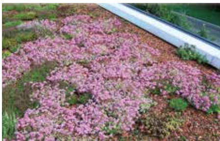
Substrat für Einfachstbegrünungen bzw. einfache Extensivbegrünungen mit Sedum
