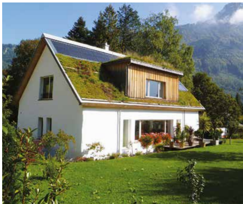
Schrägdächer bedürfen besonderer Maßnahmen zur Sicherung der Vegetation.
