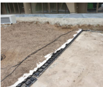
Während der Bauarbeiten auf der Tiefgaragendecke kann man die einzelnen Schichten gut erkennen.
