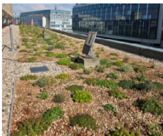
Die eingesetzten Sensoren messen die Feuchtigkeit des Substrats.
