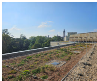
Der Streifen rund um das Gebäude wurde mit Lavendel und Mohn, sowie Stauden und der Leipziger Saatgut-Mischung begrünt.
