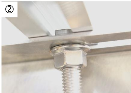
Die Hammerkopfschraube durch den Solargrundrahmen schieben. Das Montageprofil auf die Schraube schieben und mit der Sperrzahnmutter befestigen. Hier ist eine Ratsche sinnvoll. Diesen Vorgang an allen Stellen wiederholen.
