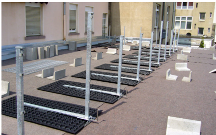
Einmessen und Auslegen der Geländerbasis GB, sowie ...
